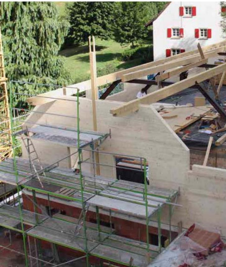
▲ Mit Massivholzelementen von Holz 100 ging es dann nach oben
