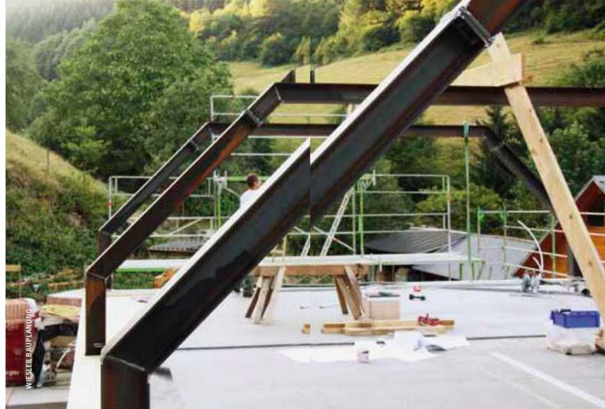
◀ Die Stahlrahmen leiten die Kräfte in die Außenwände aus
